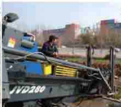
湖南郴州施工现场 Job site in Chenzhou Hunan
